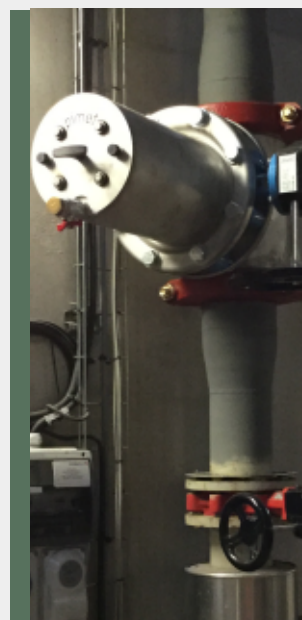
ByZon 100, exemple installation à la verticale
