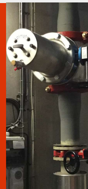
ByZon 100, exemple installation à la verticale
