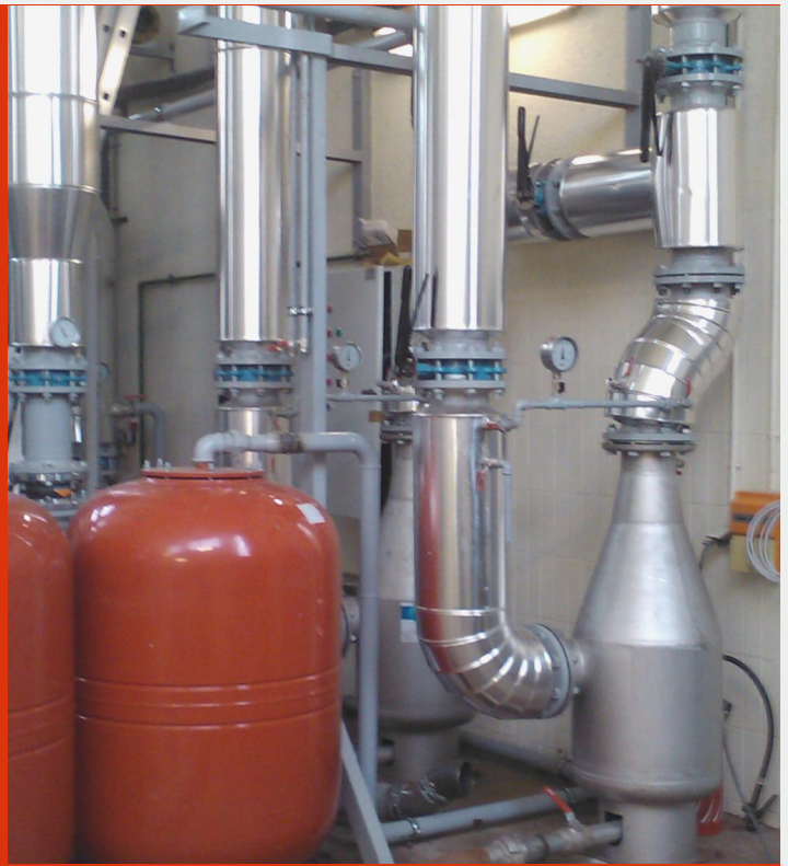
2 filtres HM 100 dans chaufferie
