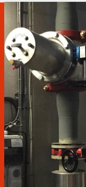
ByZon 100, exemple installation à la verticale
