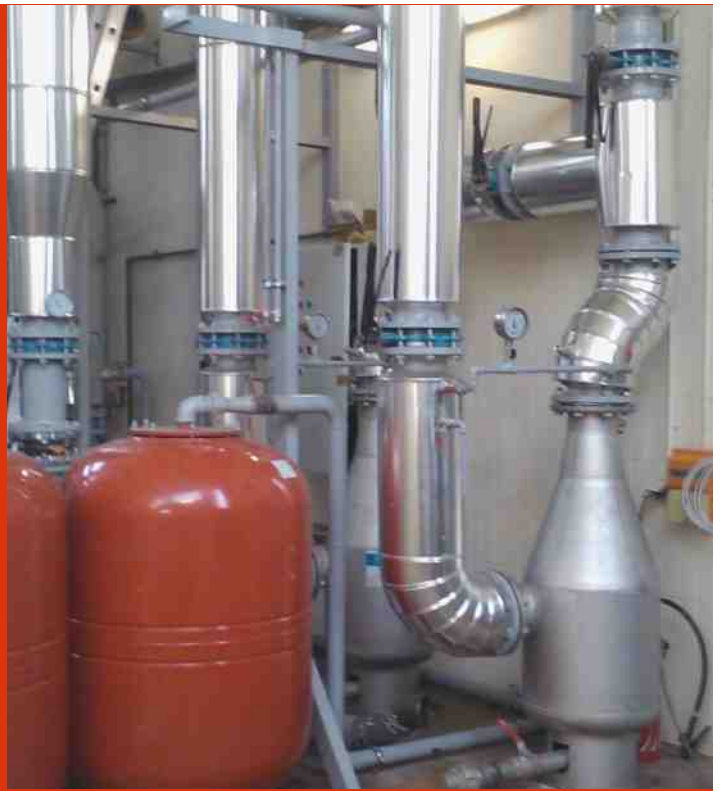
2 filtres HM 100 dans chaufferie
