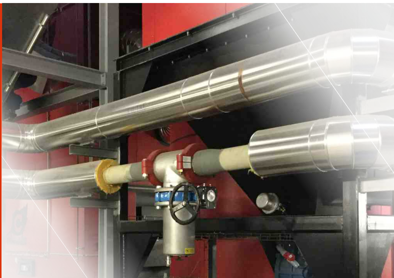
ByZon 150 installé dans une chaufferie urbaine.
